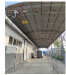
装卸区现场.jpg
