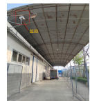
装卸区现场.jpg
