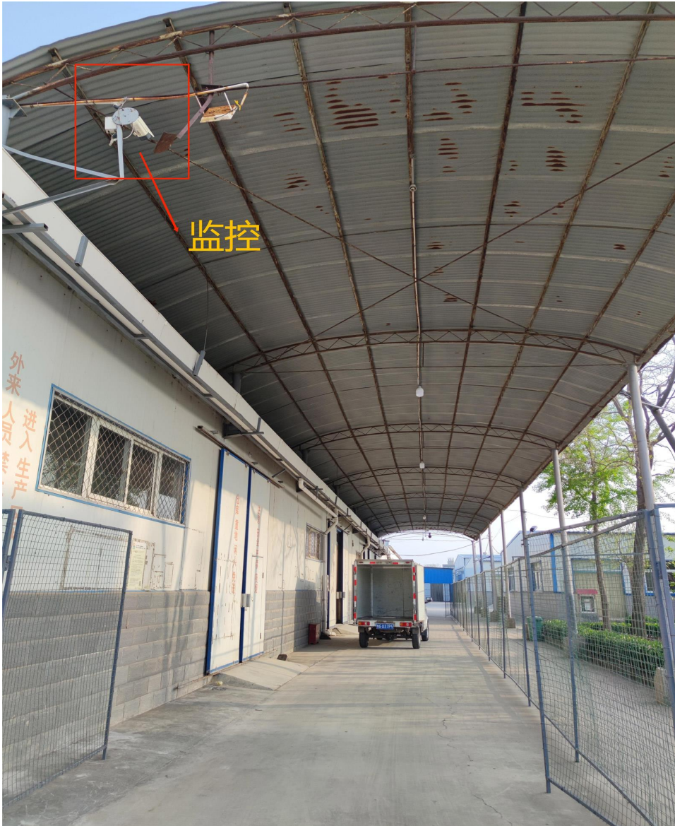
装卸区现场.jpg
