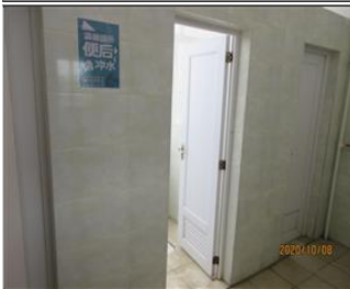
External photo(s) of the production unit(s) toilet.JPG
